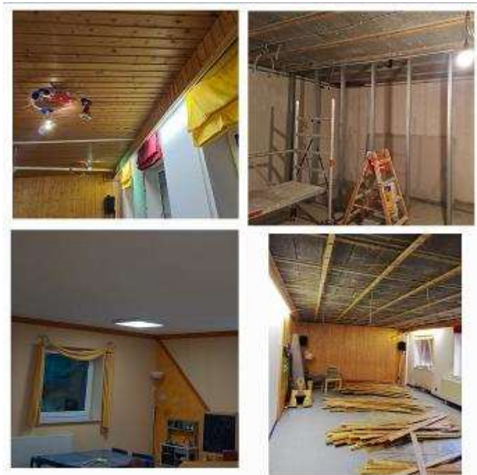
Vor und während der Renovierung
